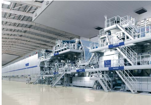
Bild 1: Eine Papiermaschine von Voith, aufgestellt und im Einsatz in der Provinz Jiangsu im Osten Chinas
