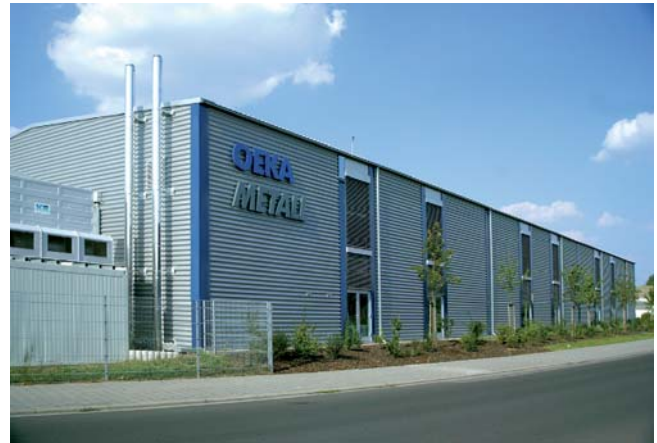
Bild 1: Oekametal-Produktionshalle in Bamberg
